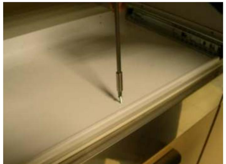
2) Fissare il basamento con le 6 viti fornite.
