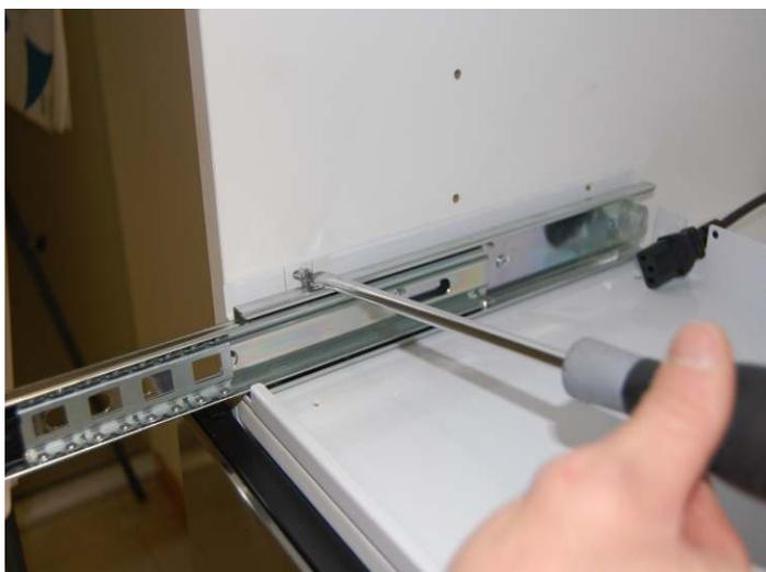
3) Fissare i lati del basamento con le 4 viti fornite. Per adeguare l'eventuale differenza di larghezza tra basamento e nicchia, piegare le alette laterali quanto basta.
